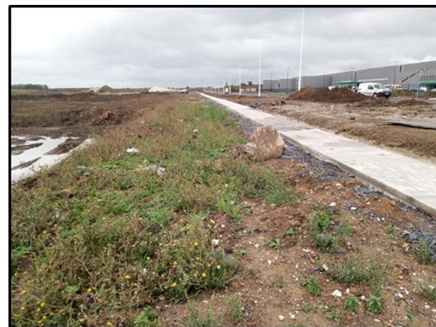
Photos 2 : site du projet (Rainette, 2019) (1/3)
