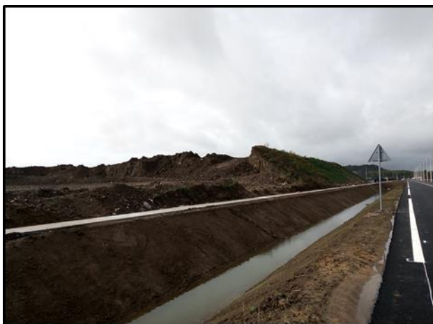
Photos 3 : site du projet (Rainette, 2019) (2/3)
